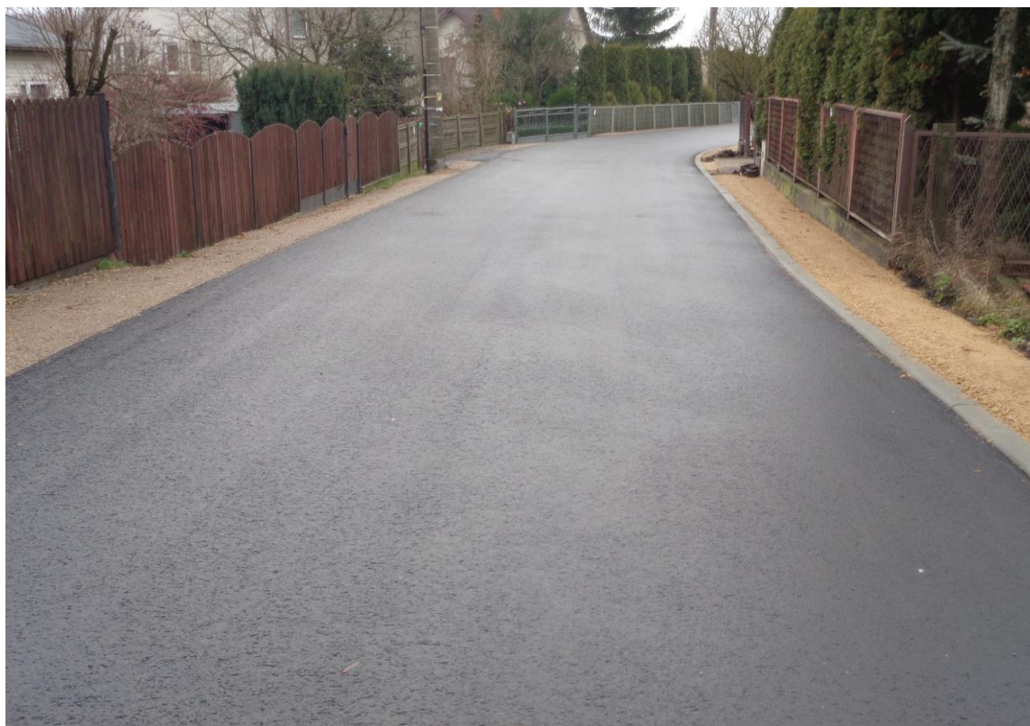
Droga po przebudowie
