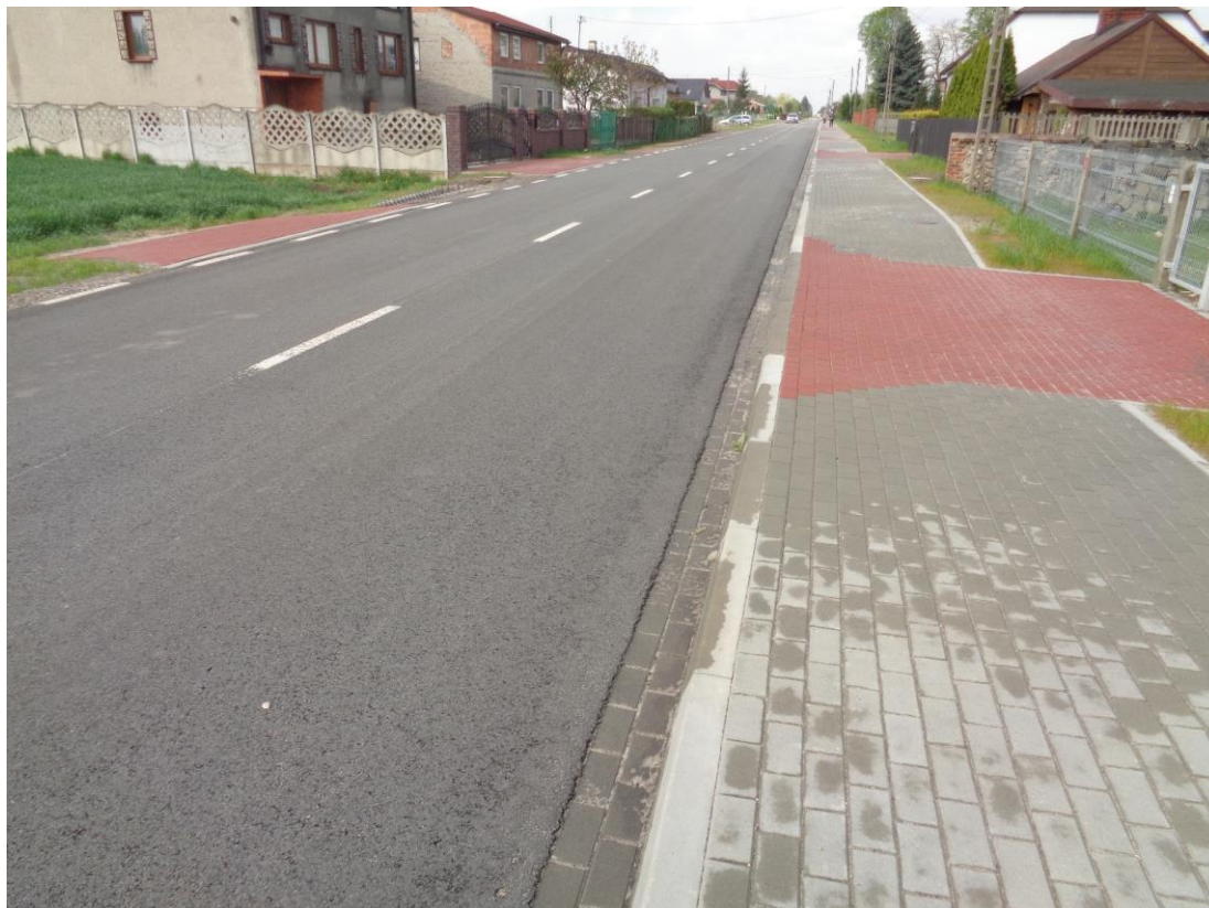
Droga po przebudowie
