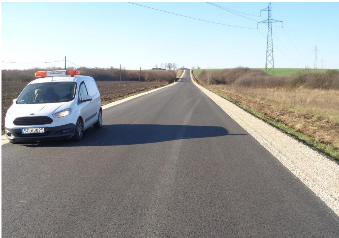
Droga po przebudowie
